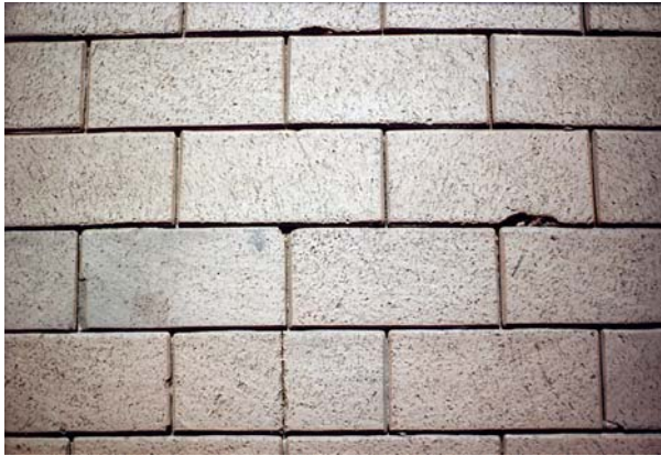
Bild 5.10: Gronau - Detail Pflaster
