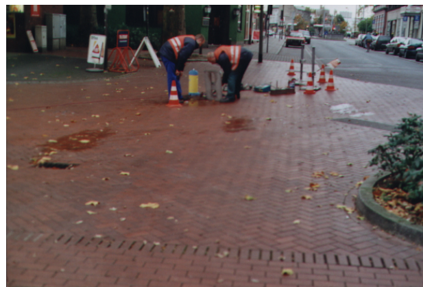
Bild 5.3: Gelsenkirchen – Gesamtansicht Aufpflasterung
