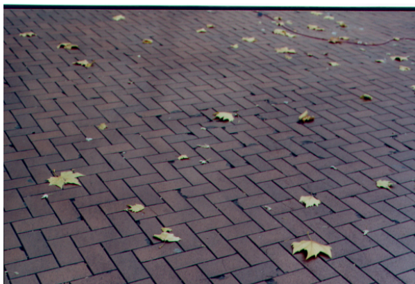
Bild 5.6: Gelsenkirchen – Pflaster Fußgängerzone
