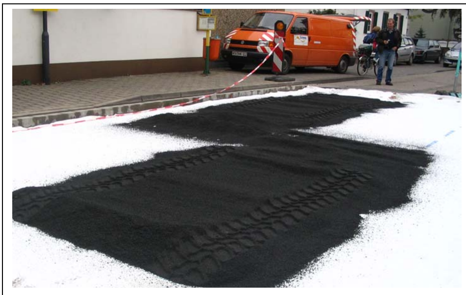
Abbildung 6-29: Verlegtes Vlies und Bettungsmaterial
