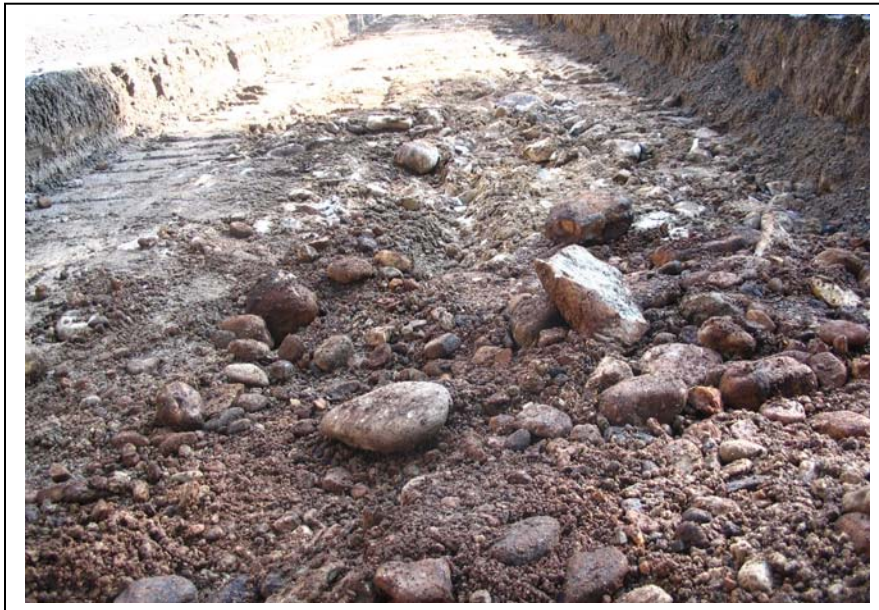
Abbildung 6-26: Untergrund im Bereich der Fahrbahnmitte vor Beginn der Arbeiten
