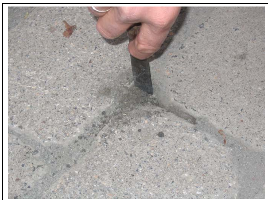
Abbildung 6-30: Überprüfung des Fugenfüllungsgrades
