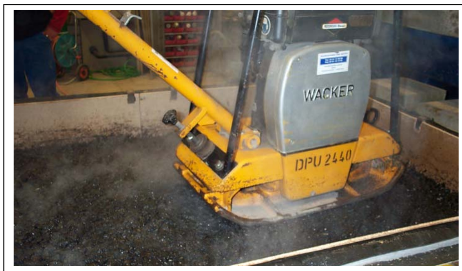
Abbildung 5-11: Einbau des WDA in die RUB-StraP
